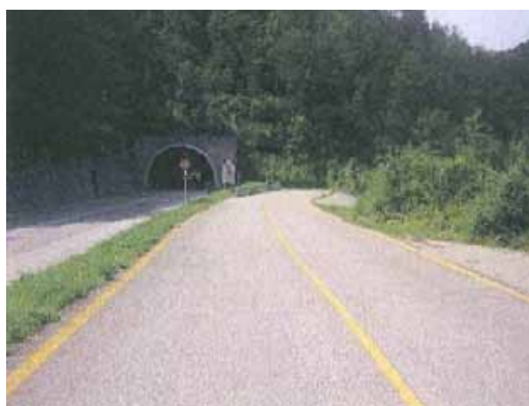
Fig. 8 – Il tratto interessato dai lavori.
