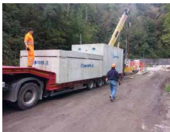
Fig. 9 – Scarico delle vasche prefabbricate.
