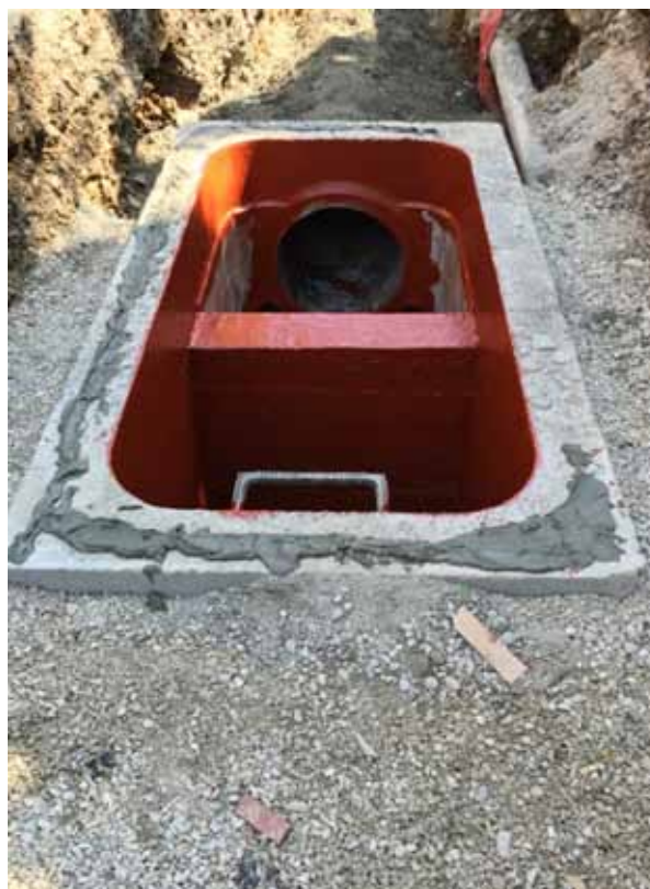
Fig. 15 – Particolare della cameretta di salto.
