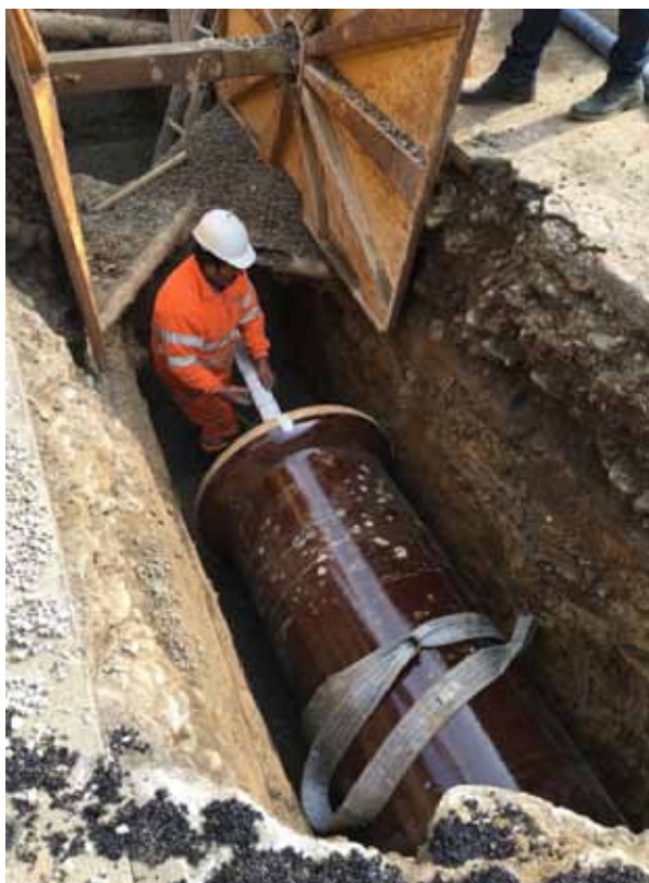
Fig. 14 – Posa condotta in grès DN 600.
