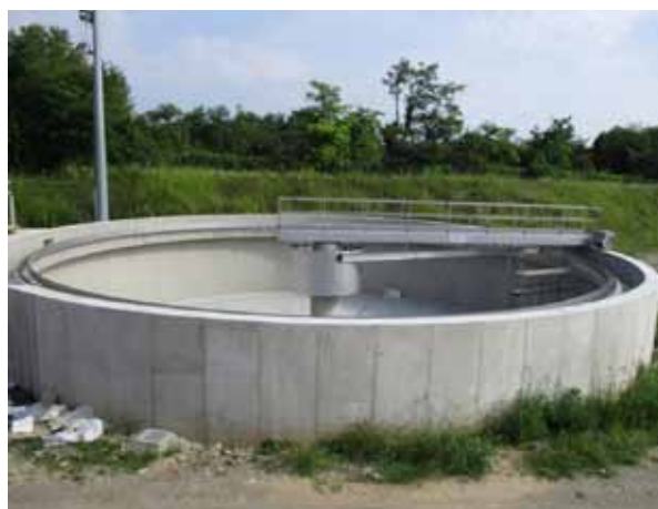
Fig. 7 – Il nuovo sedimentatore secondario
