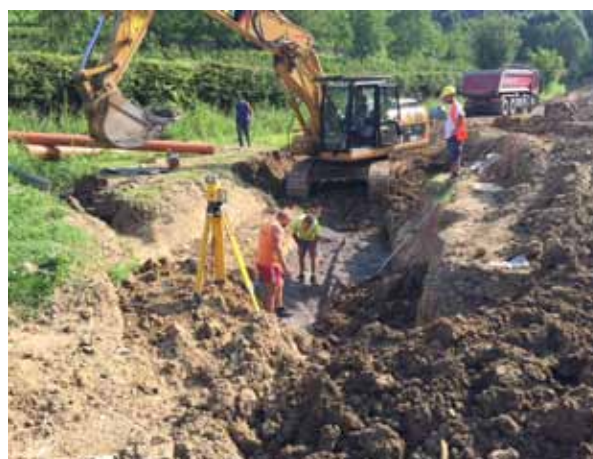
Fig. 13 – Posa delle tubazioni.
