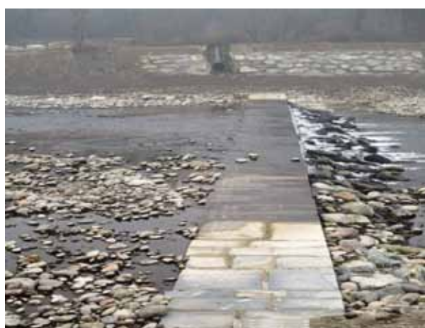
Fig. 10 – Opere di rinforzo del manufatto di protezione della tubazione.
