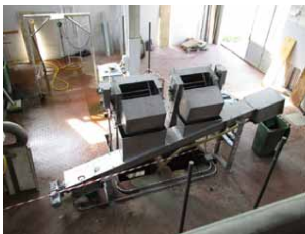
Fig. 6 – Nuove griglie e compattatore del grigliato.
