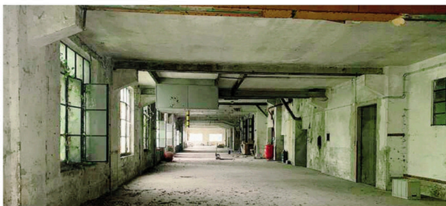
L'area della riqualificazione degli edifici storici, lungo la riva del Brembo, è di circa 520 metri quadrati
