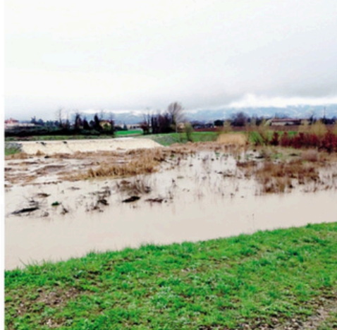
La vasca di laminazione del Lesina, a Locate di Ponte San Pietro
