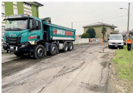
Da ieri in cantiere il Piano asfalti a Bottanuco
