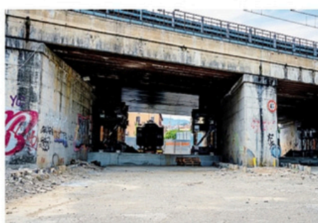
I lavori sotto il ponte di via San Bernardino AGAZZI
