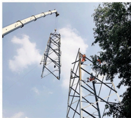
Nel 2019 furono smantellati 17 sostegni elettrici delle linee aeree
