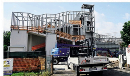
Ultimi ritocchi alla passerella. Sono stati montati gli ascensori
