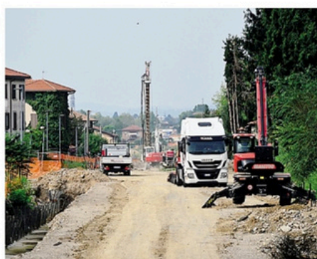
Sul cantiere del raddoppio Bergamo-Ponte mancano ancora i binari
