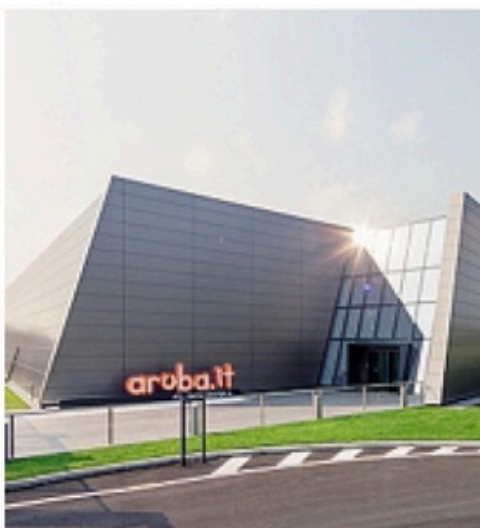
La sede a Ponte San Pietro
