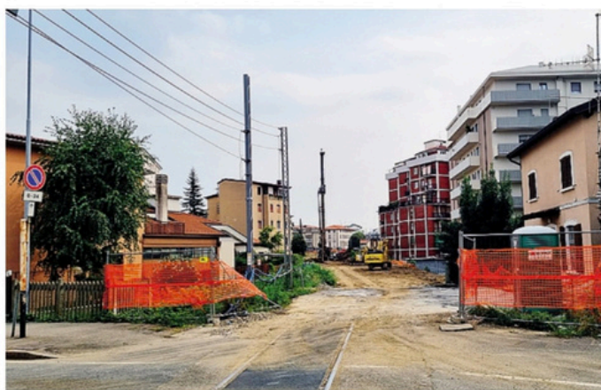
I lavori per il raddoppio ferroviario Bergamo-Ponte San Pietro
