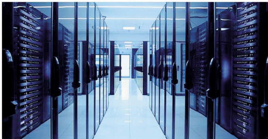
Entro un biennio la società concluderà la costruzione degli edifici del data center «D», il quarto del campus orobico
