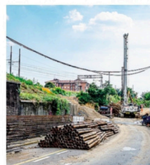
Il cantiere di via dei Caniana
