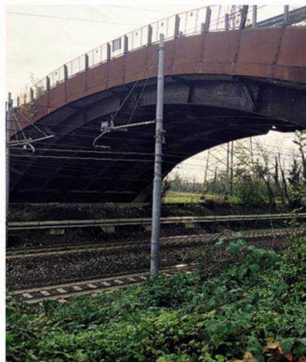
Il sovrappasso ferroviario sulla variante alla Sp98 a Civate
