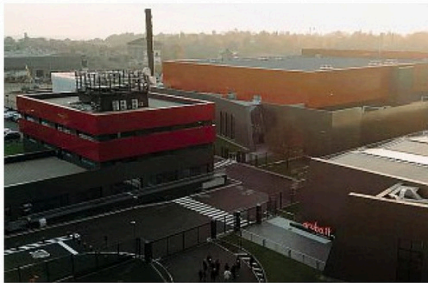
La base A Ponte San Pietro Aruba ha la sua sede principale e sta lavorando per completare il quarto blocco del proprio data center
