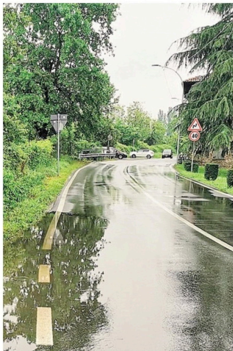
Il tratto di via Colombo dove verrà realizzato il marciapiede
