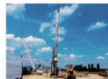
Mezzi d'opera in cantiere
