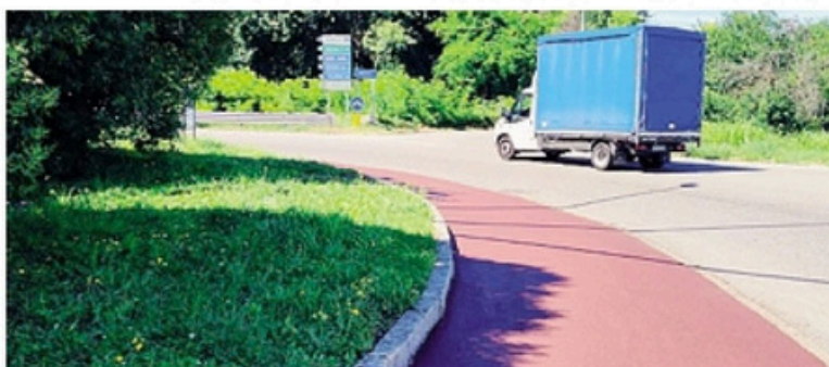
Ecco come si presenta ora, dopo l'asfaltatura
