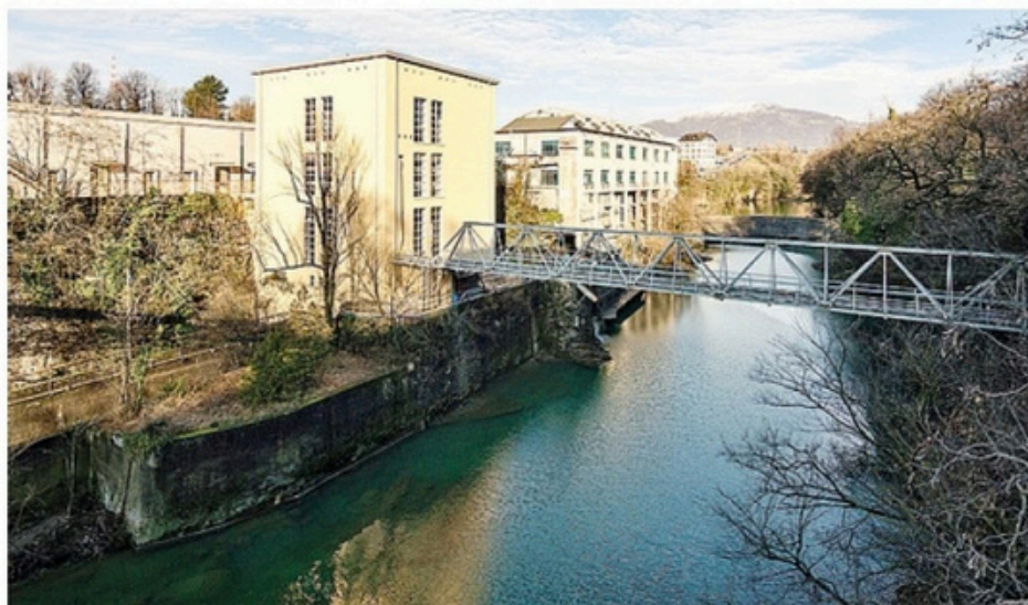
La centrale idroelettrica posizionata lungo il Brembo a Ponte San Pietro
