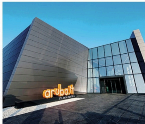
Uno dei data center all'interno del campus Aruba di Ponte San Pietro
