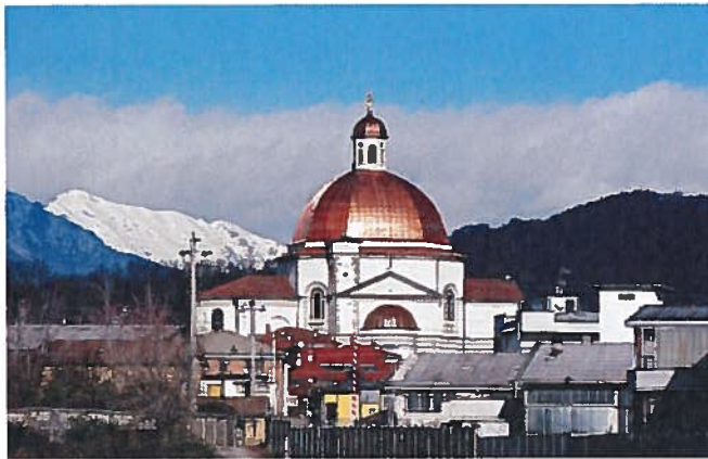
La cupola della chiesa con la nuova copertura in rame: l'intervento a 62 metri d'altezza è stato impegnativo
