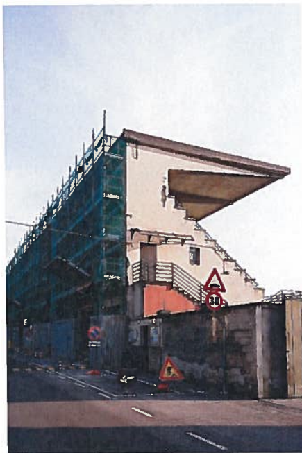
Cantiere aperto allo storico stadio comunale «Matteo Legler»
