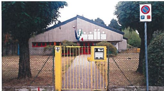
L'ingresso della scuola dell'infanzia di Briolo, in via San Marco: stanno per partire i lavori di manutenzione
