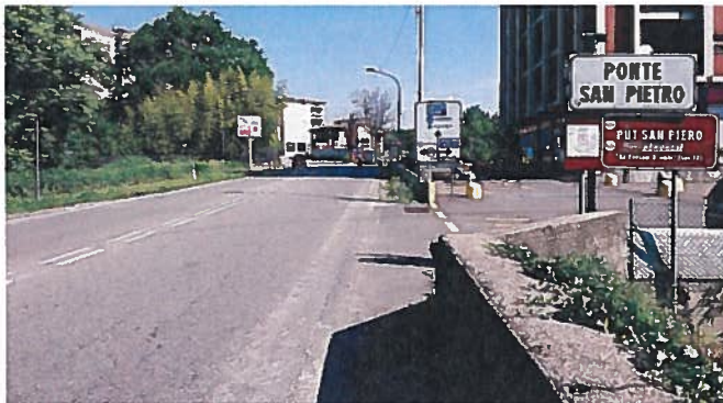
Il marciapiede sarà realizzato tra l'incrocio «Zecchetti» e il confine con Mozzo all'ex «Casa del Neonato»
