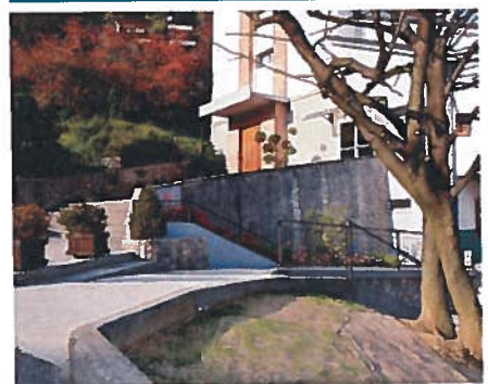
La prima rampa realizzata all'oratorio, la seconda è da costruire
