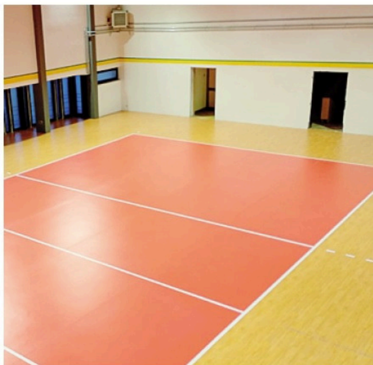
La palestra: conclusi i lavori di sistemazione
