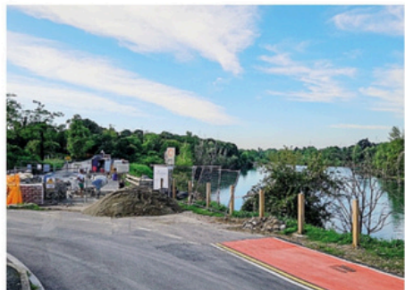
Il cantiere in corso all'ingresso dell'area
