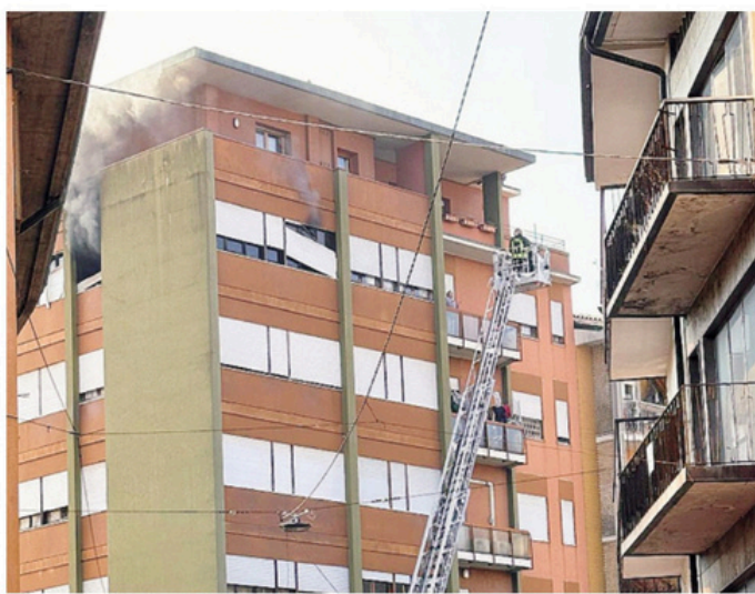
L'incendio al quinto piano del palazzo «Finazzi» tra largo IV Novembre e via Vittorio Emanuele II
