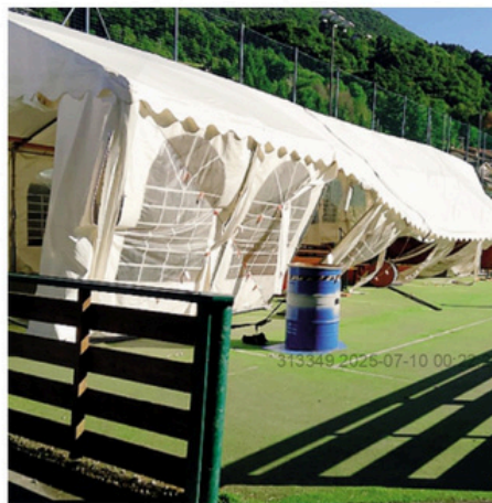
La tensostruttura del parco San Pietro a Spinone al Lago
