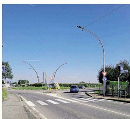
La provinciale Calusco-Ponte all'altezza di Terno d'Isola
