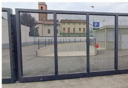
Il parcheggio sotterraneo costruito dalla Bcc
