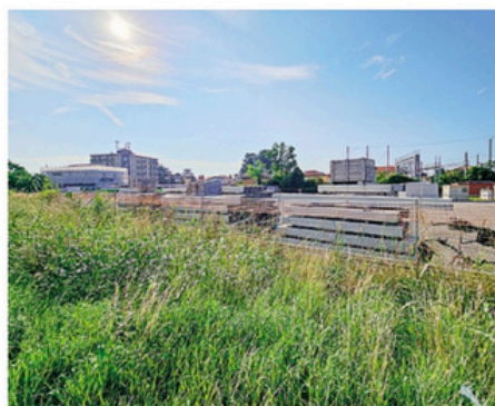
Uno scorcio del cantiere di Rfi
