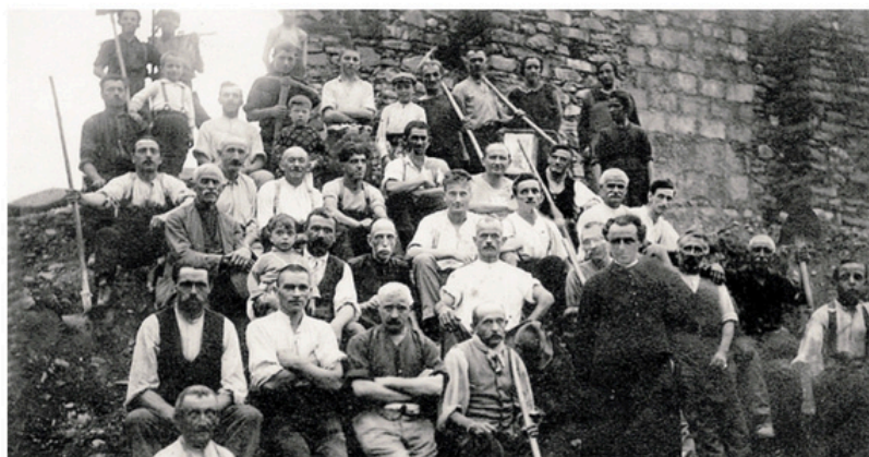
Operai impegnati nella costruzione della chiesa nuova negli Anni Venti
