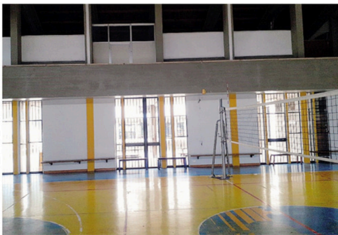
Nuovi infissi e pavimentazione per la palestra dell'oratorio a Ponte San Pietro: lavori al via dopo il Cre
