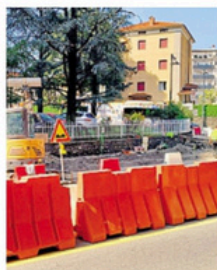
L'area di cantiere
