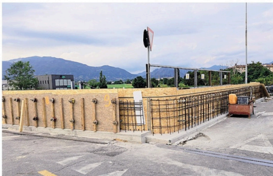
Il cantiere per l'adeguamento delle barriere di sicurezza del cavalcavia Tricorno, a Ponte San Pietro
