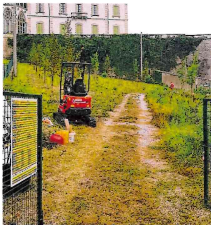
I lavori per attrezzare l'isola sensoriale della biodiversità
