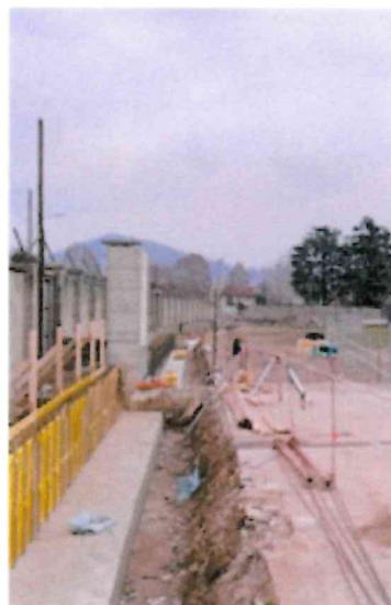
Il cantiere per la ciclabile
