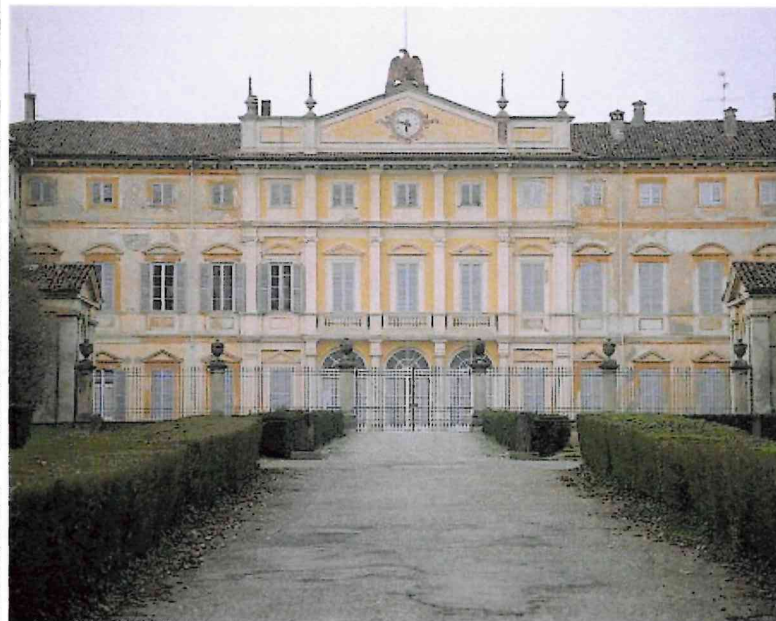
A Ponte San Pietro Villa Mapelli Mozzi: l'architetto Luigi Angelini l'aveva definita la più grandiosa delle ville della provincia
