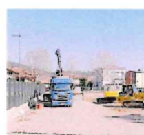
Cantieri in via Albenza
