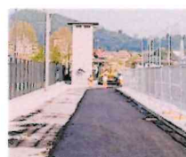
Rifacimento dell'asfalto a Briolo
