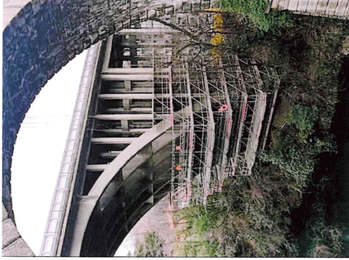
I lavori di rinforzo della parte sottostante del ponte
