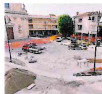
Lavori in piazza San Vittore
