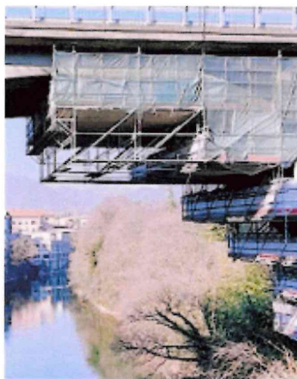
Il cantiere sotto il viadotto
