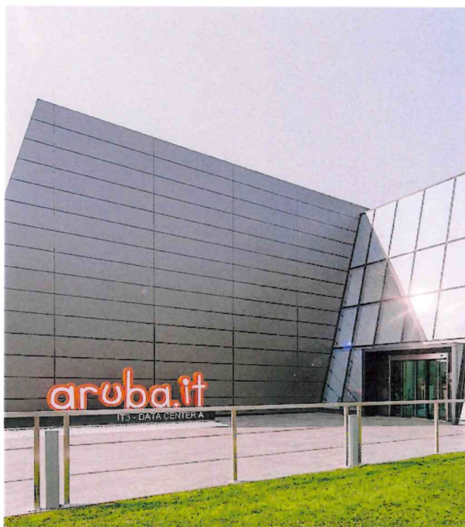
Uno degli edifici che compongono il Global Cloud Data Center di Aruba a Ponte San Pietro
