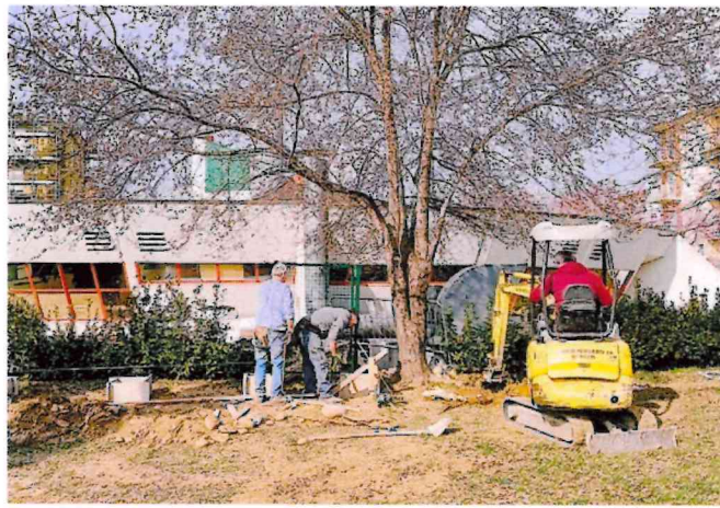
I lavori in corso nell'area del parco «Cavalier Ubiali» a Ponte San Pietro
