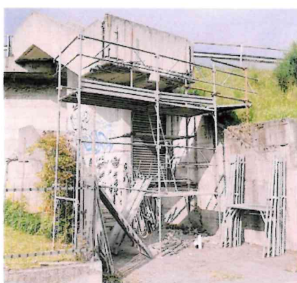
Lavori di riqualificazione in corso alla scaletta del Tricorno
