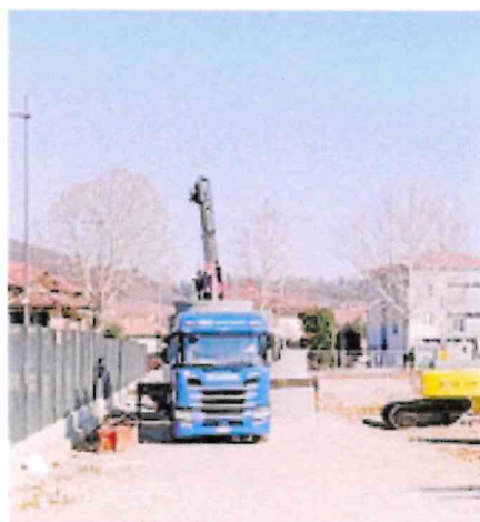
I lavori in via Albenza
