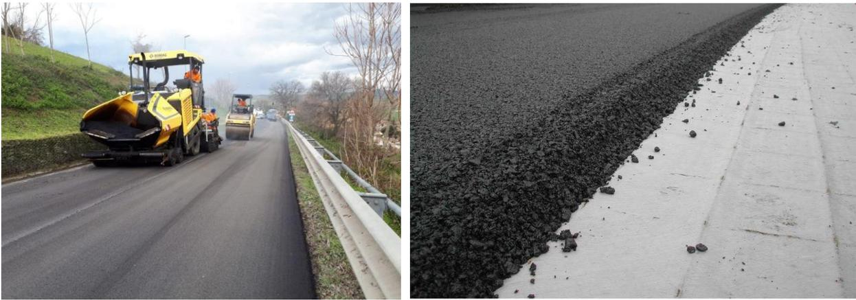
*Figura 35 – esempio di messa in posa di un tappeto di usura SMA (a sinistra), e raffigurazione del materiale (a destra)*
