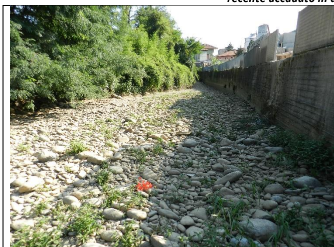
Foto 1 - Vista dell'alveo del Quisa dove si verificano le esondazioni. Tratto dove si prevede oltre che alla realizzazione della scogliera anche l'allargamento del sedime fluviale
