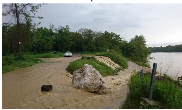
Foto 6 - Vista della tracimazione delle acque dalla strada di accesso all'Isolotto verso il F. Brembo
