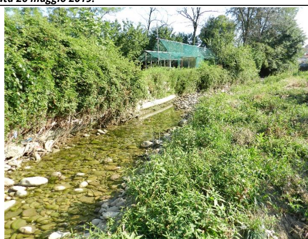
Foto 2 - Vista della zona dove si verifica l'inizio dell'esondazione verso il Paleoalveo. Tratto finale dove si prevede oltre che alla realizzazione della scogliera anche l'allargamento del sedime fluviale
