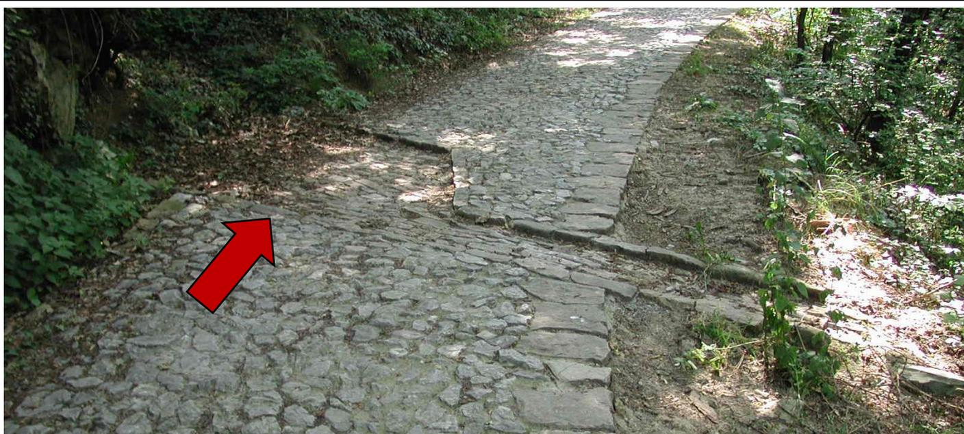
*Esempio del dettaglio del cambio di pavimentazione da realizzare con pavimentazione in smolleri e cordoli in binderi (rif. ambito D)*
