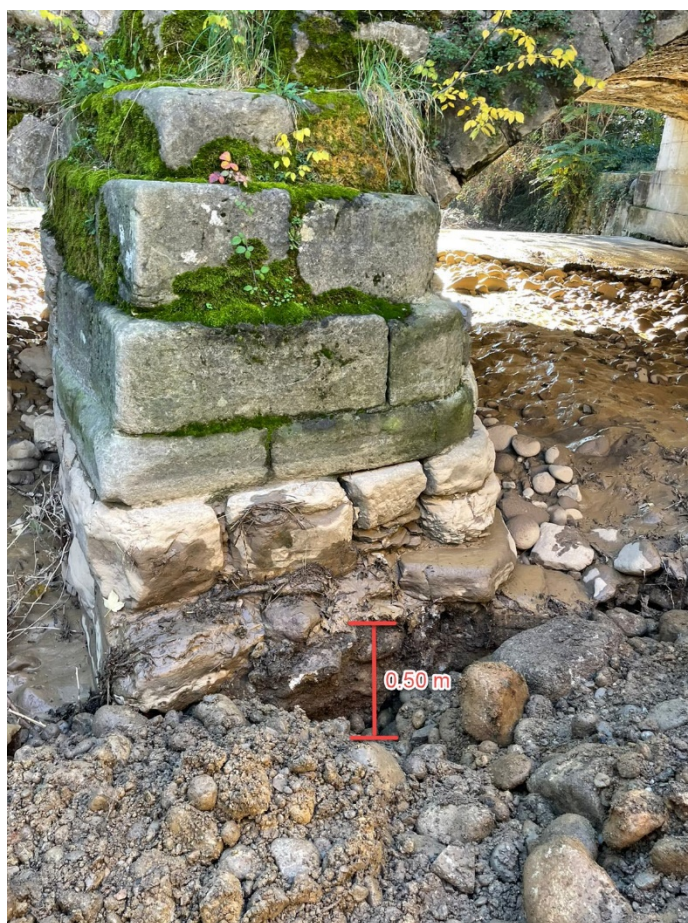
FIGURA 4 - ESITI SCAVI DI SAGGIO PER LA PILA CENTRALE DEL PONTE ESISTENTE SU VIA MERENA
