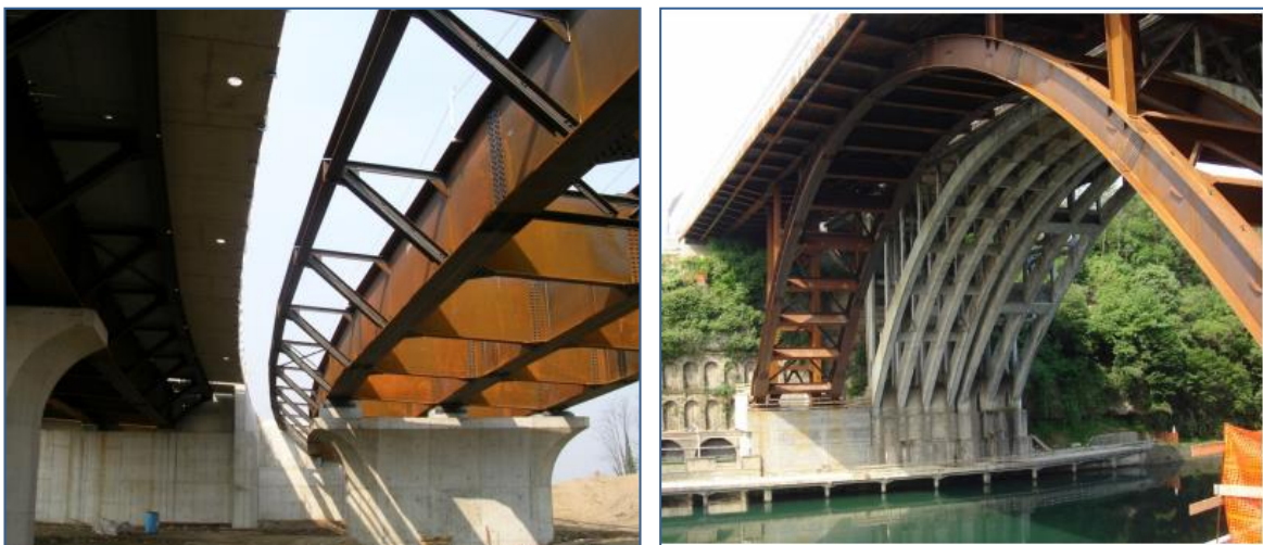
A sinistra impalcati dei ponti alla fiera di Rho-Pero, a destra l'ampliamento del ponte autostradale a Trezzo
