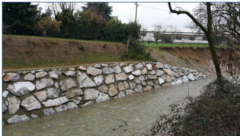
La scogliera realizzata recentemente poco a monte della posizione destinata a ospitare la nuova passerella.
