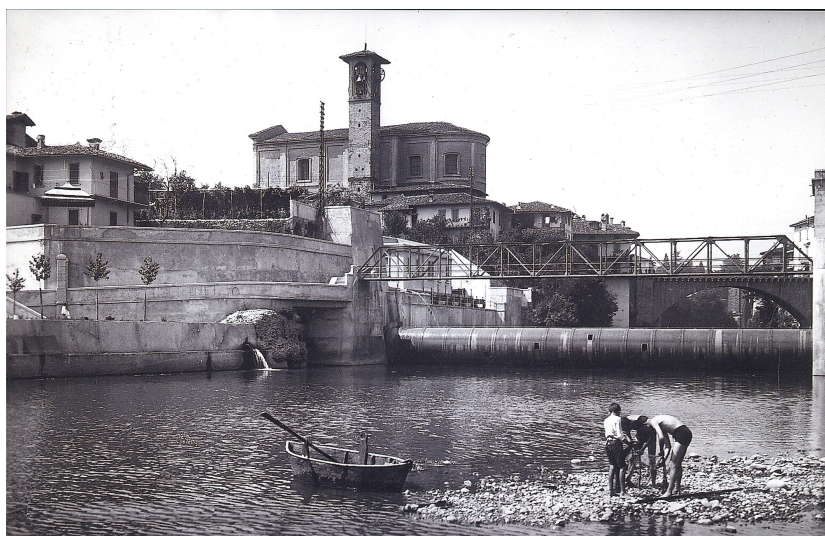
Foto 2: Traversa a valle del ponte di via Roma (per gentile concessione dell'Archivio storico dell'immagine di Ponte S. Pietro)
