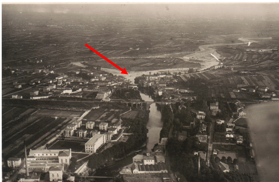
Foto 1: Foto panoramica dell'area dell'Isolotto (per gentile concessione dell'Archivio storico dell'immagine di Ponte san Pietro)
