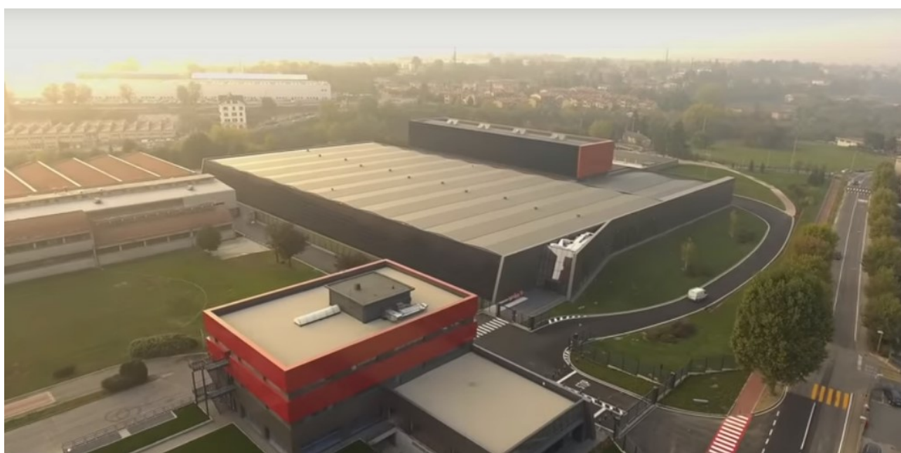
Imm. 1: vista della porzione nord del comparto, oggetto della prima fase di lavori (ottobre 2017);
