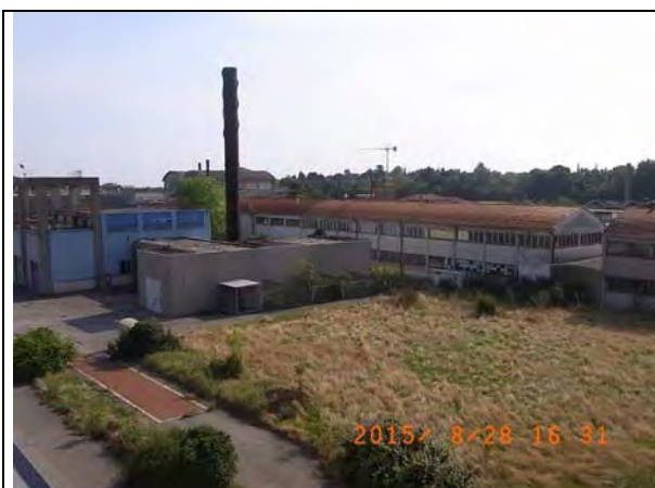
Fig. 1: Panoramica area di indagine
