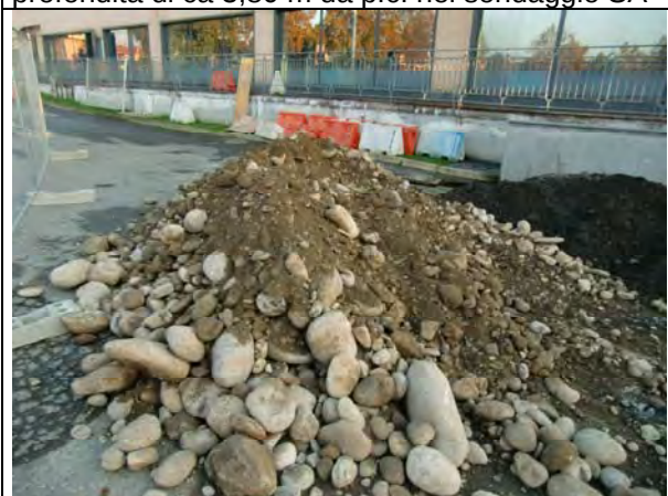
Fig. 11: Materiale estratto dagli scavi di assaggio con escavatore
