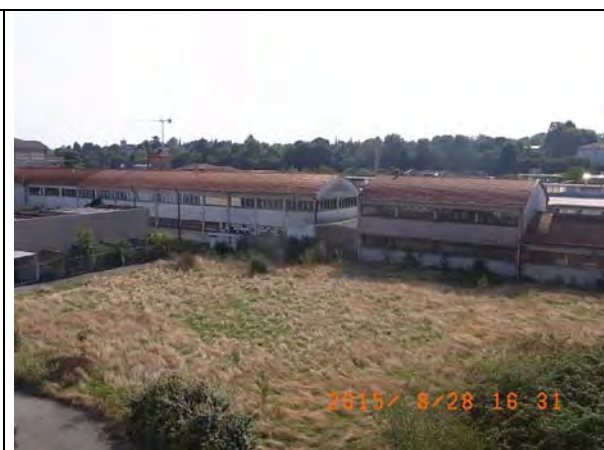
Fig. 2 Panoramica area di indagine
