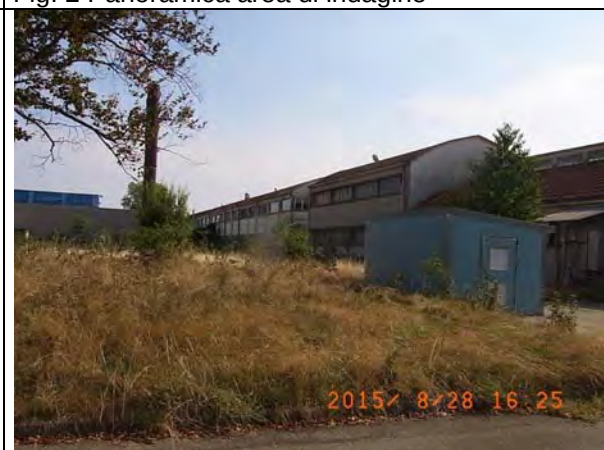
Fig. 4: Panoramica area di indagine
