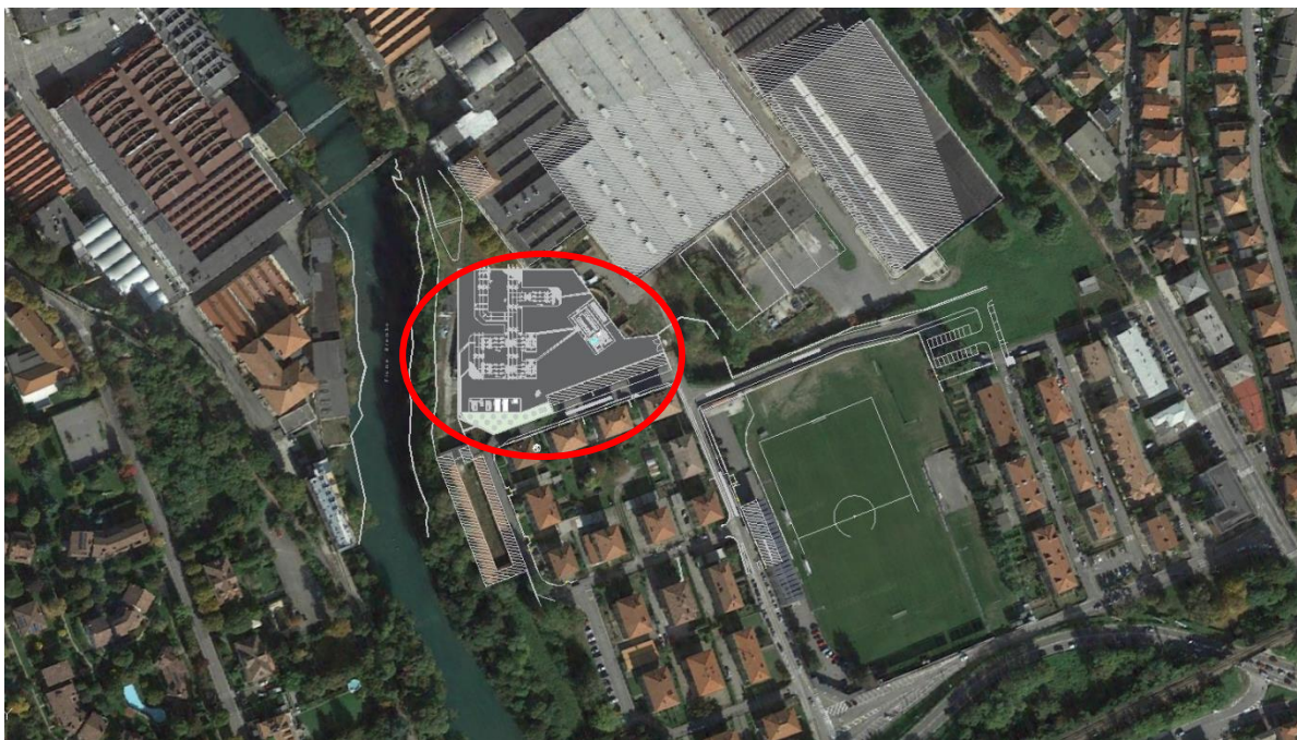
Figura 1 - Foto aerea area di intervento
